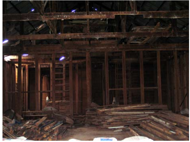
Figura 314 (à esquerda, topo) - Casa de máquinas da fazenda São Joãozinho, Lins. Destaca-se o lanternim, que serve para ventilação e iluminação internas, além de aumentar a altura para o tráfego interno pela passarela suspensa. Foto: V. Benincasa.
