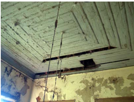
Figura 386 (acima, topo) - Vestíbulo: forro saia e camisa; notar a pintura original da parede, com motivos de gosto art-nouveau . Casarão da fazenda Riachuelo, Jaú. Foto: V. Benincasa.
