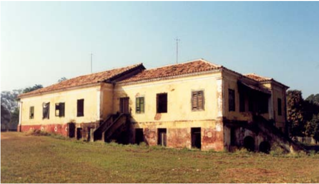
Figura 119 - Vista do escritório, à esquerda, e da casa do administrador, à direita. Fazenda Santa Veridiana, Casa Branca. Foto: V. Benincasa.
