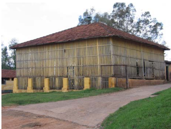
Figura 343 (topo) - Estábulo e cocheira. Fazenda Santo Inácio, São Manuel. Foto: V. Benincasa.
