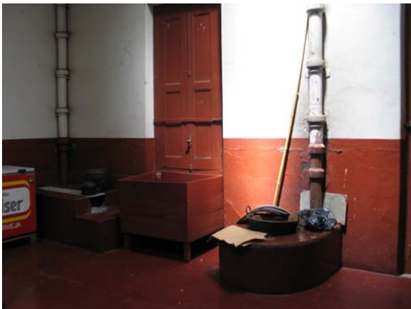
Figura 488 (acima) - Aspecto da cozinha "suja": inexistência de forro para facilitar a dispersão do calor. Casarão da fazenda Boa Vista, Ribeirão Preto. Foto: V. Benincasa.
