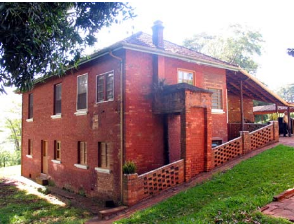
Figura 524 (acima, topo) - Casarão da fazenda Santo Inácio, em São Manuel, construída em 1935. A casa segue o mesmo padrão das demais edificações do conjunto da fazenda: alvenaria de tijolos aparentes, uso de concreto armado na estrutura. Foto: V. Benincasa.
