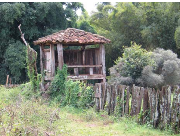
Figura 48 - Detalhe de fachada de paiol, com aberturas para ventilação. Fazenda Invernada, Morro Agudo. Foto: V. Benincasa.
