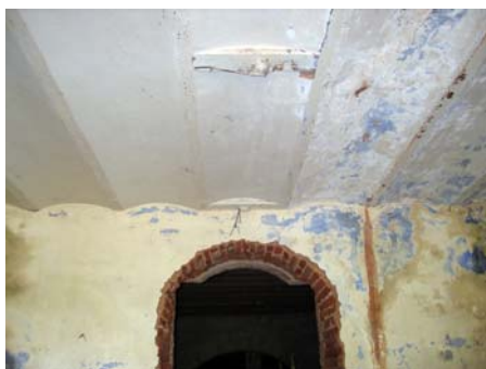
Figura 56 (acima) - Detalhe das abobadilhas abaixo do alpendre fronteiro. Casarão da fazenda Saltinho, São Manuel. Foto: V. Benincasa.
