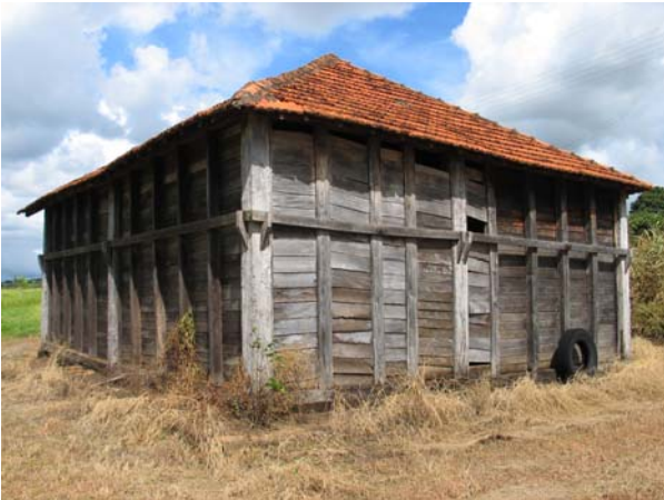
Figura 299 (acima, topo) - Detalhe do sistema estrutural: as travas são seguras por garras de madeira, fixadas nos pilares estruturais. Tulha da fazenda Santa Ana, Estrela d'Oeste. Foto: V. Benincasa.
