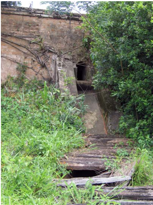
Figura 226 (à esquerda, topo) - Detalhe do sistema de drenagem de águas superficiais. Terreiro da fazenda Santa Isabel, Cafelândia. Foto: V. Benincasa.
