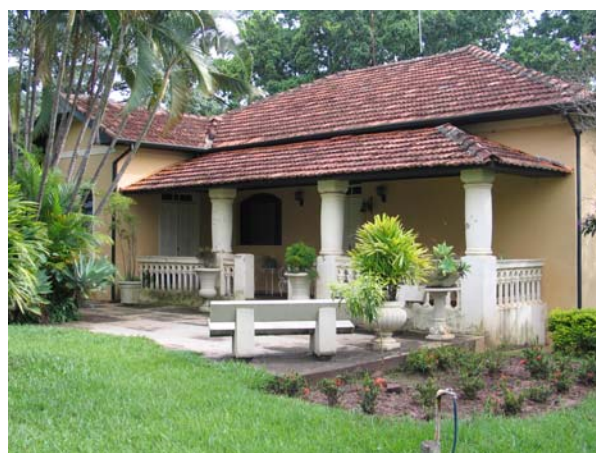
Figura 468 - Fachada do casarão da fazenda Bela Vista, em Catiguá. Notar as colunas galbadas, e o guarda-corpo feito com elementos pré-fabricados de cimento armado. Foto: V. Benincasa.
