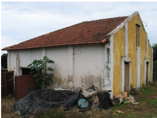
Figura 287 - Fachada da tulha da fazenda Bonsucesso, Pongaí. Observar a porta no pavimento superior e a marca da antiga escadaria, descendo pelo lado direito da foto. Foto: V. Benincasa.
