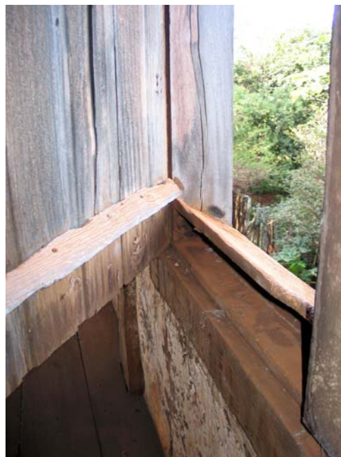
Figura 65 - Outro detalhe, observar as janelas com aletas para o escoamento das águas pluviais para fora do peitoril. Sobrado das mucamas, fazenda São Gilberto, Sales Oliveira. Foto: V. Benincasa.
