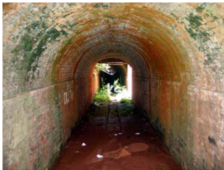
Figura 266 (acima, topo) - Outra vista do interior do túnel das vagonetas: observar as moegas por onde eram despejados os grãos secos de café. Fazenda Salto, em São Manuel. Foto: V. Benincasa.
