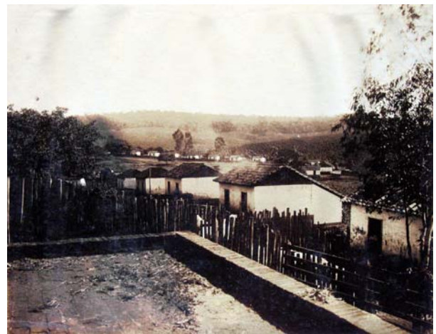
Figura 106 - Casa de máquinas. Fazenda Redenção, São Manuel. Foto: V. Benincasa.
