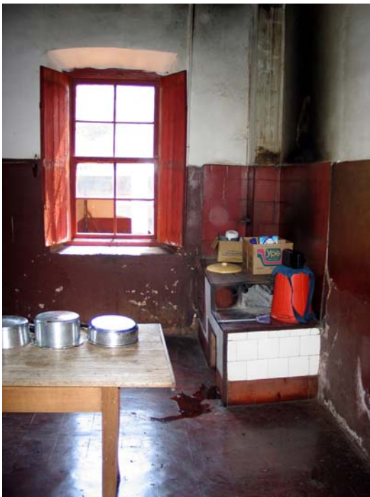
Figura 503 (acima, topo) - Aspecto parcial da cozinha, com a porta voltada para o pátio posterior. O revestimento da parede não é original. Casarão da fazenda Salto, de São Manuel. Foto: V. Benincasa.
