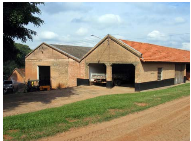
Figura 336 (acima, topo) - Depósito. Fazenda Ventura, Cafelândia. Foto: V. Benincasa.
