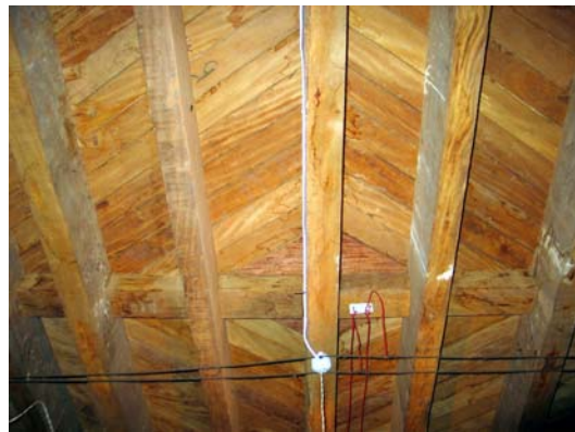
Figura 502 (acima, topo) - Vista do anexo de serviços. Casarão da fazenda Brejão, Casa Branca. Foto: V. Benincasa.
