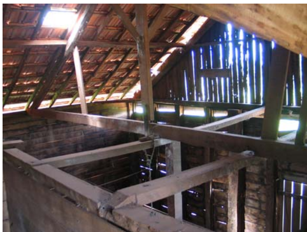
Figura 294 (acima, topo) - Tulha de madeira da fazenda Santa Ana, Estrela d'Oeste. Exemplar com passarela chegando em água furtada Foto: V. Benincasa.
