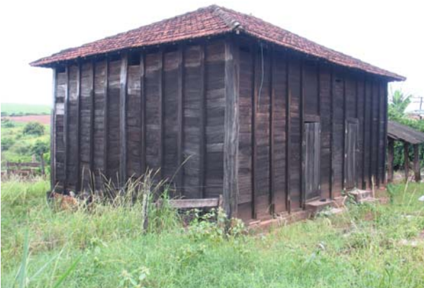
Figura 292 (à esquerda, embaixo) - Tulha da fazenda Santa Luciana, Jaci. Exemplar de tulha de madeira, dentro dos novos padrões, porém anexada a uma casa de máquinas, construída em alvenaria de tijolos. Foto: V. Benincasa.
