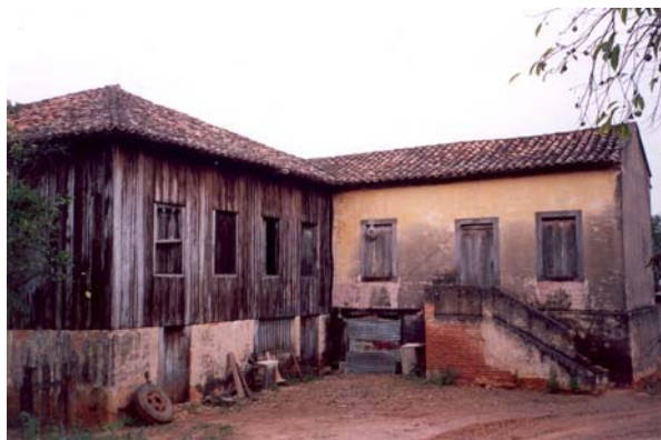
Figura 34 (à direita) - Vista traseira do casarão da fazenda Boa Vista, Tietê. Notar as paredes de madeira e de taipa de mão. Foto: Suelito de Campos Moraes.
