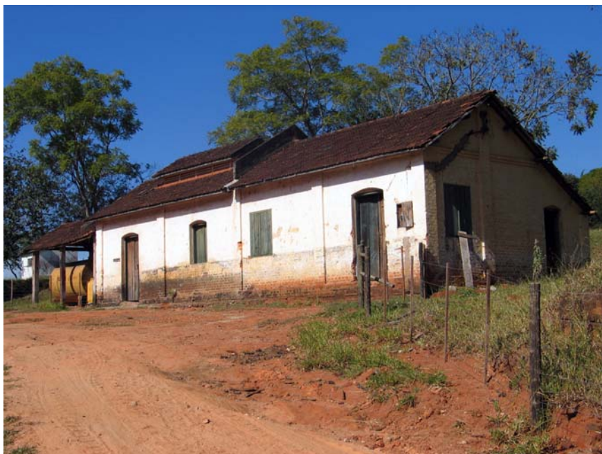
Figura 181 - Casa de torrefação de café e, ao lado, o tanque de combustível. Fazenda São João do Tibiriçá, Gália. Foto: V. Benincasa.
