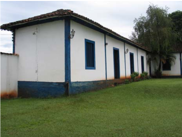
Figura 39 (acima, topo) - Vista externa da senzala, que contorna o pátio interno. Fazenda Invernada, Morro Agudo. Foto: V. Benincasa.
