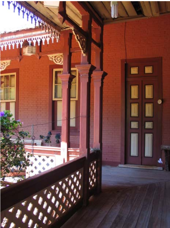
Figura 468 (à esquerda) - Alpendre interno: pilastras, guarda-corpo e lambréquins de madeira. Casarão da fazenda Boa Vista, Ribeirão Preto. Foto: V. Benincasa.
