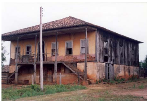
Figura 33 (à direita, topo) - Fachada do casarão da fazenda Boa Vista, Tietê. Notar as paredes de taipa de mão, na fachada da edificação, e a de alvenaria de madeira na lateral e, também, o desenho diferenciado dos pinázios das guilhotinas. Foto: Suelito de Campos Moraes.
