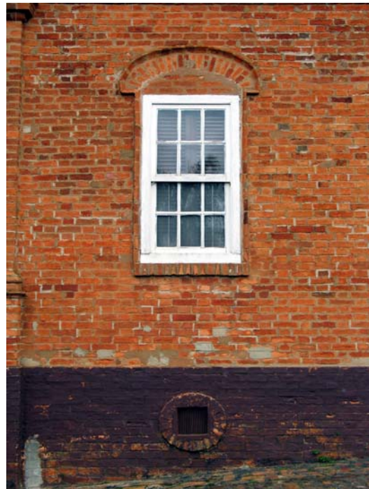
Figura 123 (acima) - Detalhe de fachada lateral: notar o arco de escarção, sobre a janela; o círculo formado por peças cerâmicas que envolvem o óculo do porão; e o aparelho, ou modo de assentamento dos tijolos, de tipo flamengo. Casarão da fazenda Madureira, de Tietê. Foto: V. Benincasa.
