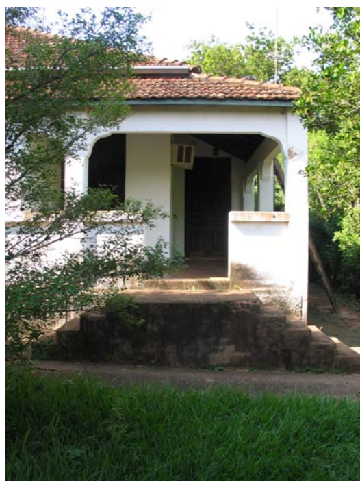
Figura 441 (à direita, embaixo) - Casa do administrador: construída parcialmente em madeira, sobre alicerces de tijolos. Fazenda Santo Inácio, São Manuel. Foto: V. Benincasa.
