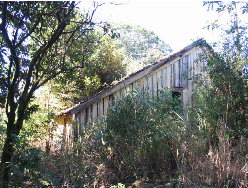
Figura 129 - Casa de madeira de colônia da fazenda Santana, São Carlos. Foto: V. Benincasa.
