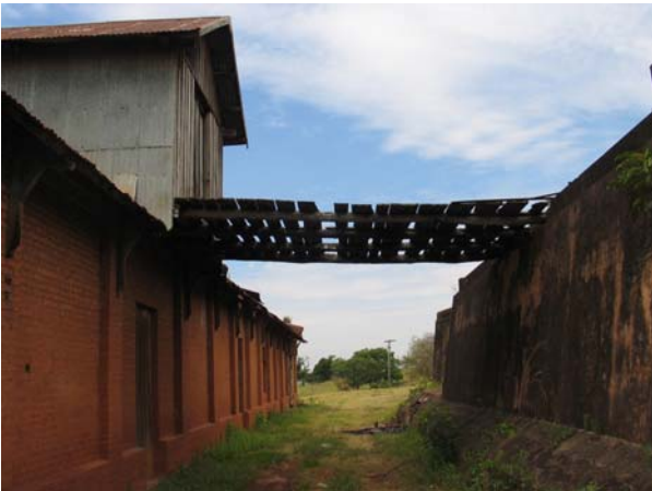
Figura 314 (à esquerda, topo) - Casa de máquinas da fazenda São Joãozinho, Lins. Destaca-se o lanternim, que serve para ventilação e iluminação internas, além de aumentar a altura para o tráfego interno pela passarela suspensa. Foto: V. Benincasa.
