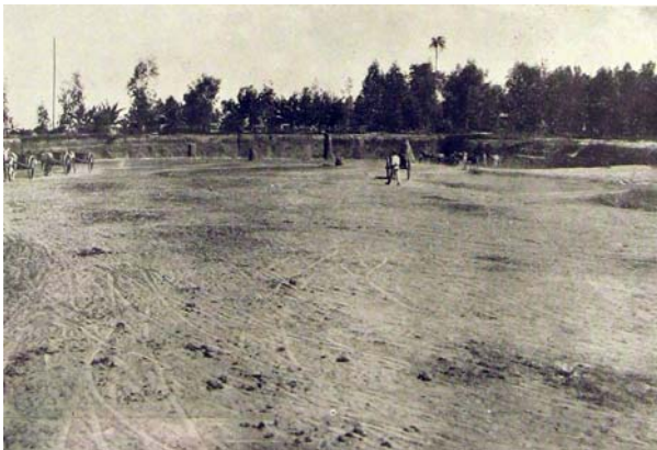
Figura 234 (acima) - Rara foto de terreiro em execução: notar os cortes no relevo natural, e as carroças que transportavam a terra retirada. Fazenda Suíça, Lins. Fonte: Almanaque da Noroeste . São Paulo: Pan-Americana, 1928, p. 354.
