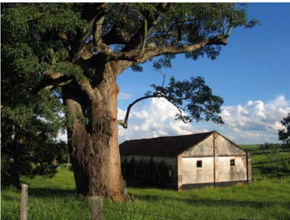
Figura 323 (à esquerda, topo) - Tulha e casa de máquinas, fazenda Cafeeira, Braúna. Foto: V. Benincasa.
