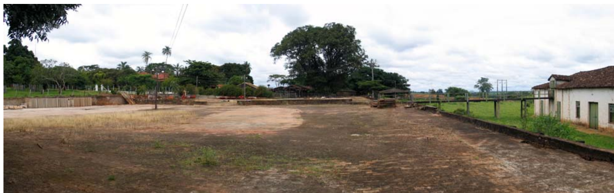
Figura 225 (acima) - Muros de arrimo externos dos terreiros da fazenda Santa Isabel, Cafelândia. Notar o gigante na quina do terreiro e a leve inclinação para descarregar de maneira mais eficaz as forças resultantes. Foto: V. Benincasa.
