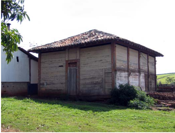
Figura 29 - Paio edificado em madeira. Fazenda São José, Nuporanga. Foto: V. Benincasa.
