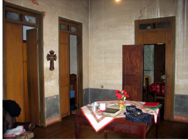
Figura 481 (à esquerda, topo) - Aspecto interno do alpendre: ao fundo a entrada do escritório; à direita, a porta de acesso à moradia. Casarão da fazenda Bonsucesso, em Pongáí. Foto: V. Benincasa.
