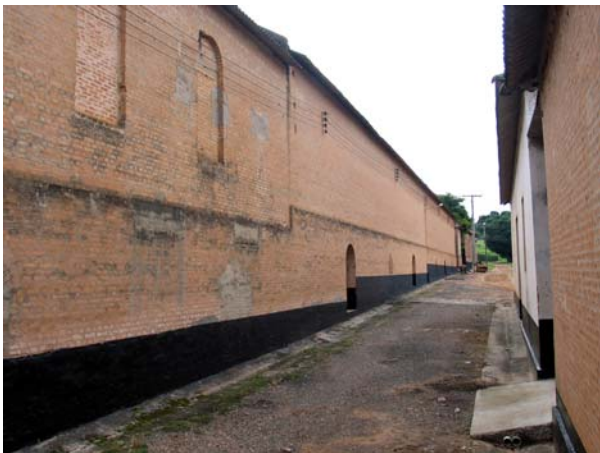
Figura 306 (acima, topo) - Detalhe de fachada da casa de máquinas da fazenda Igrê, Garça. Pode se observar a água furtada por onde entrava a passarela vinda do terreiro. O piso do terreiro foi posteriormente rebaixado e, atualmente, o café é conduzido para as tulhas mecanicamente. Foto: V. Benincasa.
