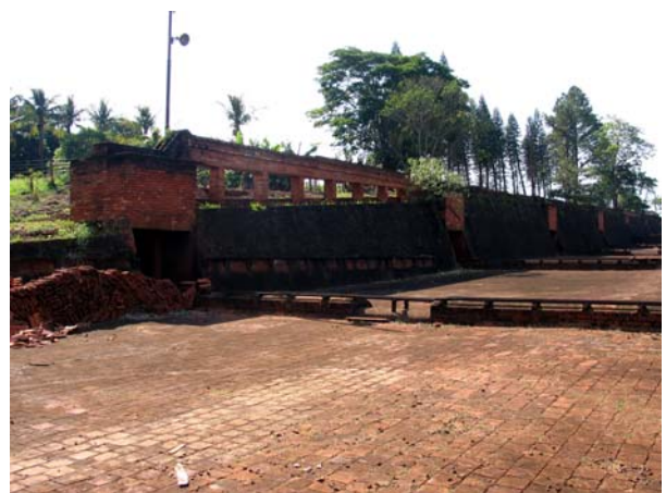
Figura 253 - Vista superior da canaleta situada na lateral do terreiro, para condução do café, juntamente com a água, do lavador para as plataformas de secagem. Fazenda Santo Inácio, São Manuel. Foto: V. Benincasa.
