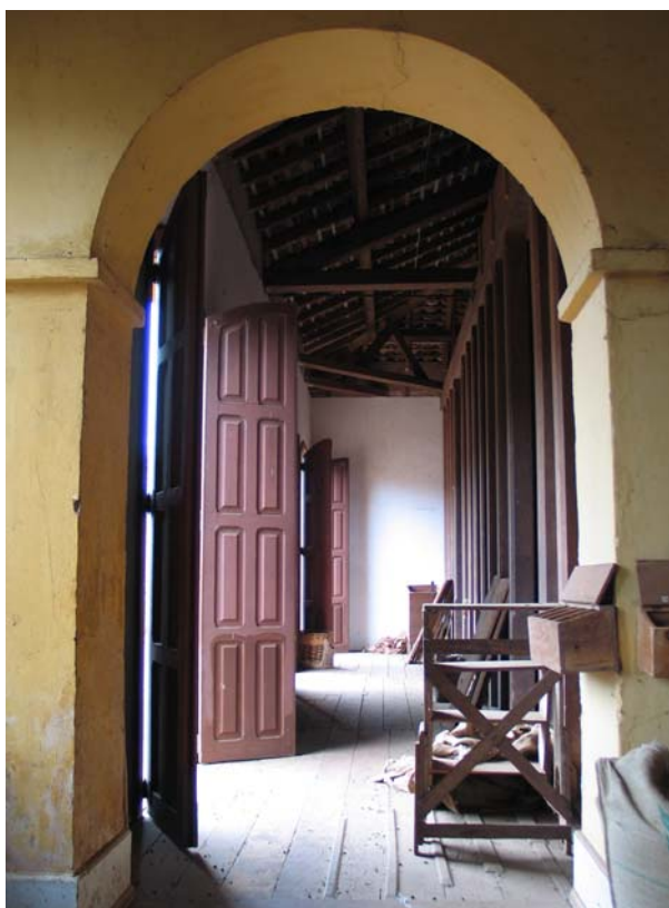
Figura 199 (à esquerda, topo) - Aspecto interno da serraria. Fazenda Brejão, Casa Branca. Foto: V. Benincasa.
