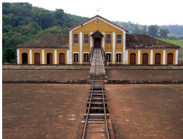
Figura 192 (à direita, topo) - Outro aspecto dos terreiros, com trilhos desmontáveis para vagonetas. Ao fundo, a casa de máquinas. Fazenda Brejão, Casa Branca. Foto: V. Benincasa.
