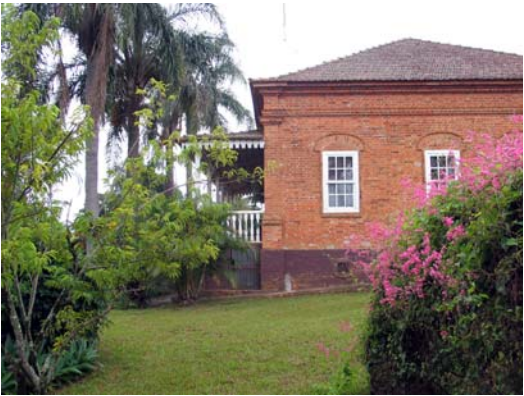
Figura 120 (acima, topo) - Detalhe de cunhal: notar o capitel e fuste da pilastra. Fundos do casarão da fazenda Madureira, de Tietê. Foto: V. Benincasa.
