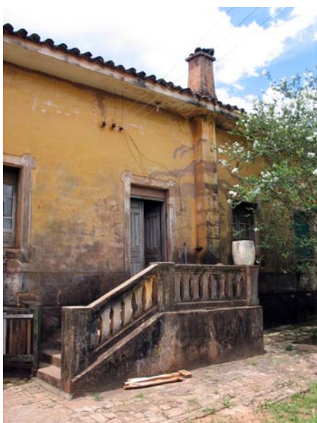
Figura 530 (à esquerda, centro) - Vista das aberturas para aumentar o nível de iluminação do alpendre e da sala de estar. Casarão da fazenda Ventura, Cafelândia. Foto: V. Benincasa.
