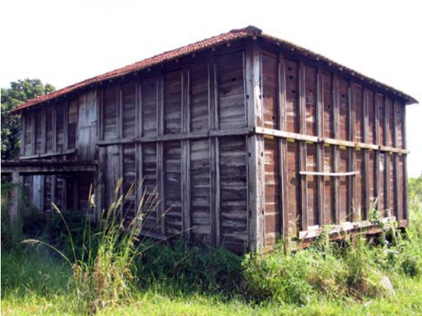
Figura 290 (à esquerda, topo) - Tulha da fazenda Boa Vista, Balsamo. Nesse caso, o acesso entre tulha e terreiro é feito por passarela. Observar a bonita estrutura de pilares externos, seguros por trava horizontal, além de tirantes internos de ferro, para absorver melhor a tração exercida pelo peso do café. Notar que as tábuas que formam a vedação da edificação estão encaixadas em sulcos existentes nos pilares: não são contínuas. Foto: V. Benincasa.
