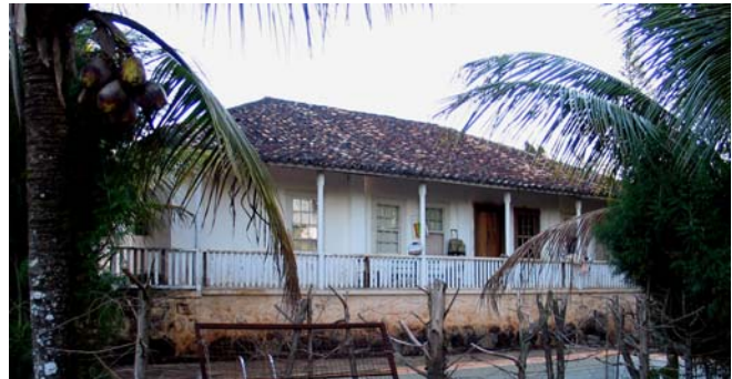
Figura 295 - Casarão da fazenda da Bandeira, Descalvado. Foto: V. Benincasa.
