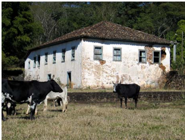
Figura 302 (à esquerda, centro) - Fachada do casarão, voltada para os terreiros. Fazenda Monjolinho, em Itirapina. Foto: V. Benincasa.
