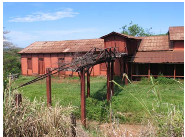
Figura 185 (acima) - Passarela de ligação entre terreiros e tulha: a estrutura de madeira praticamente desapareceu, sobrando os trilhos das vagonetas. Fazenda Boa Vista, Ribeirão Preto. Foto: V. Benincasa
