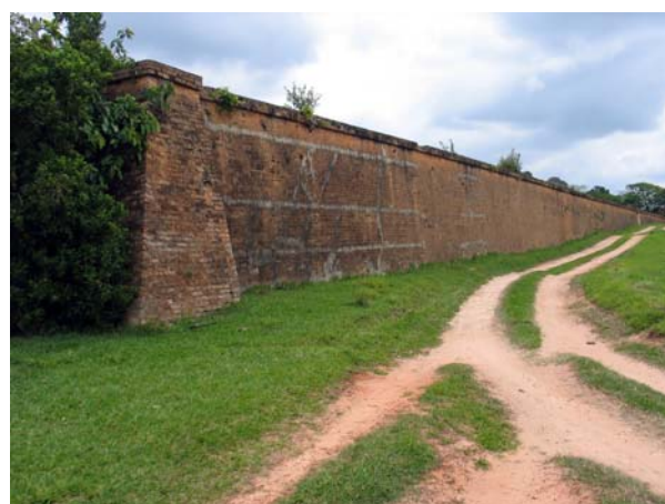
Figura 224 (acima, topo) - Vista geral dos terreiros da fazenda Mangue, em Jaci. Os arrimos, em alvenaria de tijolos, foram feitos à maneira tradicional com muros verticais que, talvez pela falta de manutenção, não suportaram a tração exercida e necessitaram de reforços de pilares de concreto. Foto: V. Benincasa.
