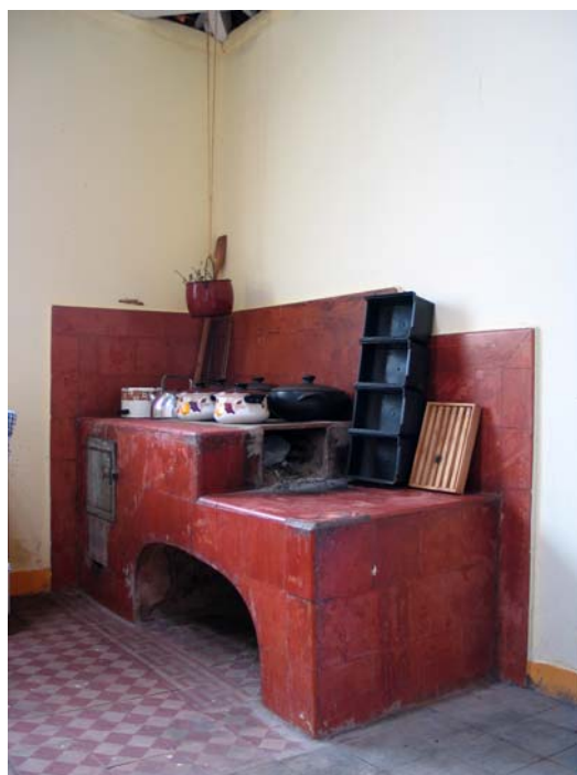
Figura 465 (à esquerda, topo) - Detalhe do forno da sala de estar, em dois níveis, com as aberturas para ventilação. Casarão da fazenda Santa Luzia, de Catanduva. Foto: V. Benincasa.
