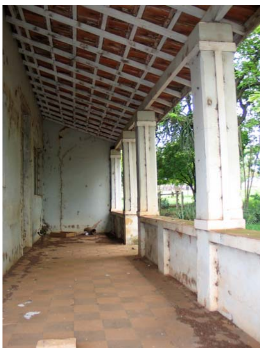
Figura 469 (à esquerda, topo) - Fachada do casarão da fazenda São Joãozinho, em Lins. Foto: V. Benincasa.
