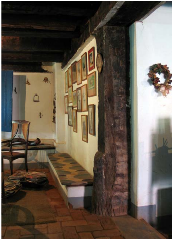
Figura 8 (acima) - Outro aspecto do porão, onde se observa o pilar de sustentação da estrutura da casa, parcialmente lavrado a enxó. Fazenda Nova, Mococa. Foto: V. Benincasa.
