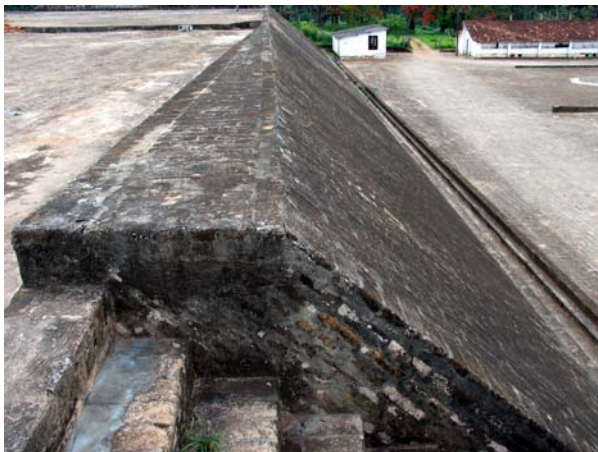
Figura 231 (à esquerda, centro) - Berma e talude entre duas plataformas do terreiro. Fazenda Chantebled, Júlio de Mesquita. Notar, na parte inferior, o sistema de drenagem. Foto: V. Benincasa.
