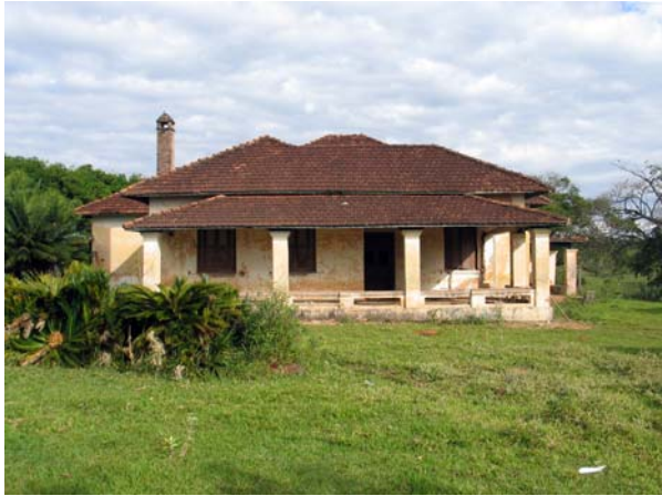
Figura 197 - Fachada da casa do fiscal. Fazenda São João do Tibiriçá, Gália. Foto: V. Benincasa.
