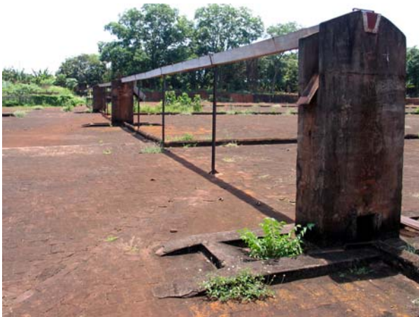
Figura 255 (à esquerda) - Canaleta metálica suspensa, sobre pilares de alvenaria: notar a abertura por onde água e café eram despejados sobre a peneira, ao pé do pilar. Terreiro da fazenda Salto, São Manuel. Foto: V. Benincasa.
