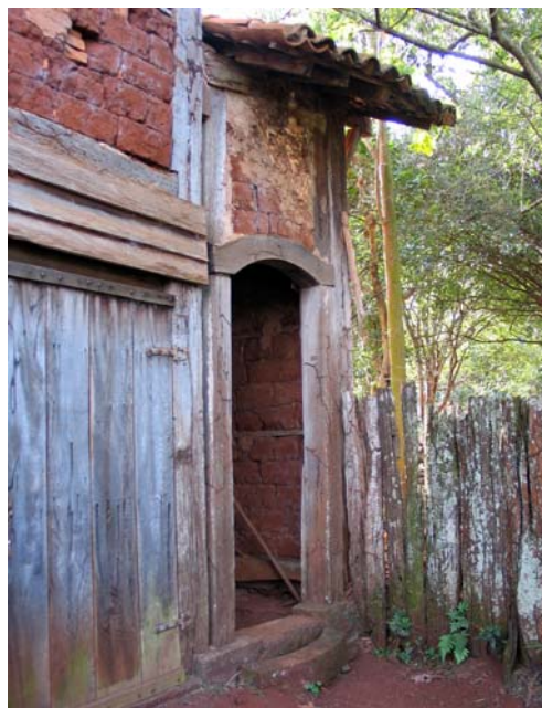
Figura 59 (à esquerda, centro) - Vista da face posterior do sobrado das mucamas. Junto aos beirais se percebem restos da antiga argamassa de recobrimento das paredes. À esquerda, o corpo anexo da escada de acesso ao pavimento superior. Fazenda São Gilberto, Sales Oliveira. Foto: V. Benincasa.
