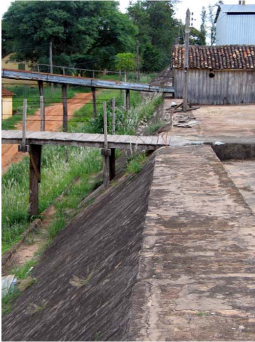
Figura 230 (à esquerda, topo) - Outra vista da lateral do terreiro da fazenda Chantebled, Júlio de Mesquita. Aqui, a berma e o talude estão ainda revestidos somente de tijolos, sem a argamassa. Notar as passarelas que interligam terreiro e tulha. Foto: V. Benincasa.
