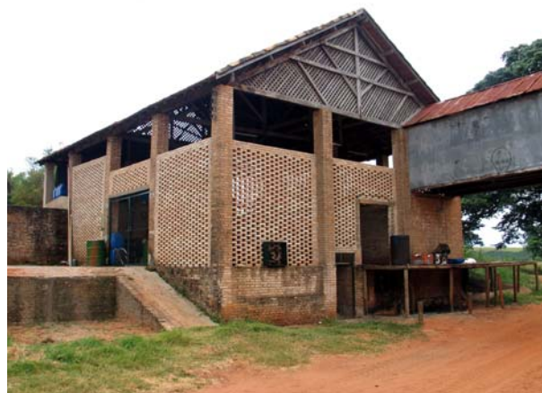
Figura 306 (acima, topo) - Detalhe de fachada da casa de máquinas da fazenda Igrê, Garça. Pode se observar a água furtada por onde entrava a passarela vinda do terreiro. O piso do terreiro foi posteriormente rebaixado e, atualmente, o café é conduzido para as tulhas mecanicamente. Foto: V. Benincasa.
