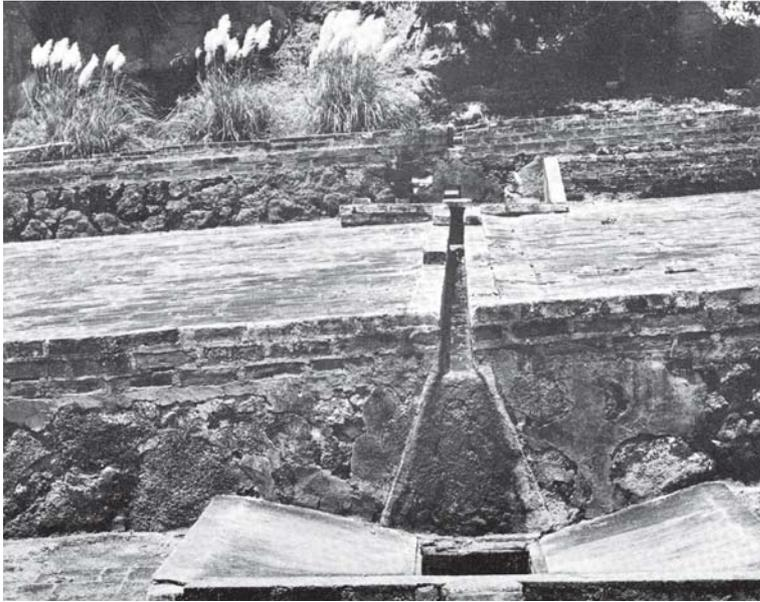
Figura 41 - Vista dos canais de distribuição do café lavado e moega de recepção. Notar a alvenaria de pedra dos arrimos e o acabamento em tijolos. Fazenda São Bento, Morungaba. Foto: Antonio Carlos Bellia. Fonte: *Cadernos de Fotografia nº 5 – Fazendas do Ciclo do Café, Região de Campinas*. São Paulo: Secretaria de estado da Cultura, s/d.
