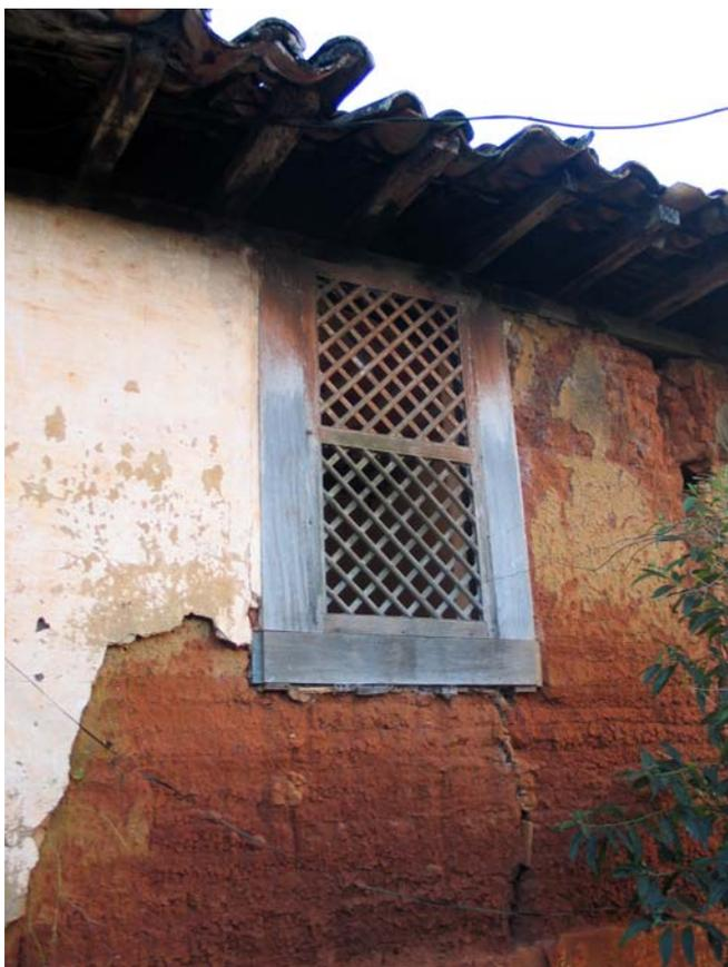
Figura 158 - Aspecto externo da casa do feitor, com janela protegida por treliça de madeira, na face voltada ao pátio dos escravos. Fazenda Engenho das Palmeiras, Itapira. Foto: V. Benincasa.
