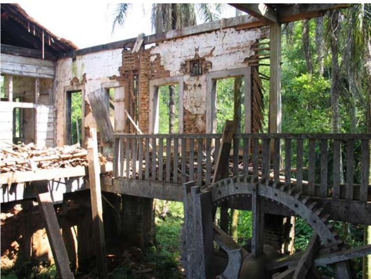
Figura 58 - Vista interna do primeiro engenho de café da fazenda Engenho das Palmeiras, onde podemos observar a passarela, uma parede feita com alvenaria de madeira, e paredes em taipa de mão, em Itapira. Foto: V. Benincasa.
