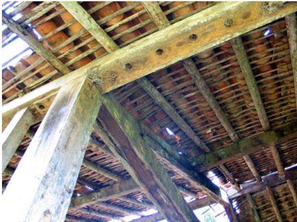
Figura 60 (acima) - Detalhe da estrutura da edificação, onde podem ser vistos: o frechal com os respectivos encaixes dos paus-a-pique, e a estrutura da cobertura com troncos de macaúba, palmeira comum na região. Fazenda Engenho das Palmeiras, Itapira. Foto: V. Benincasa.
