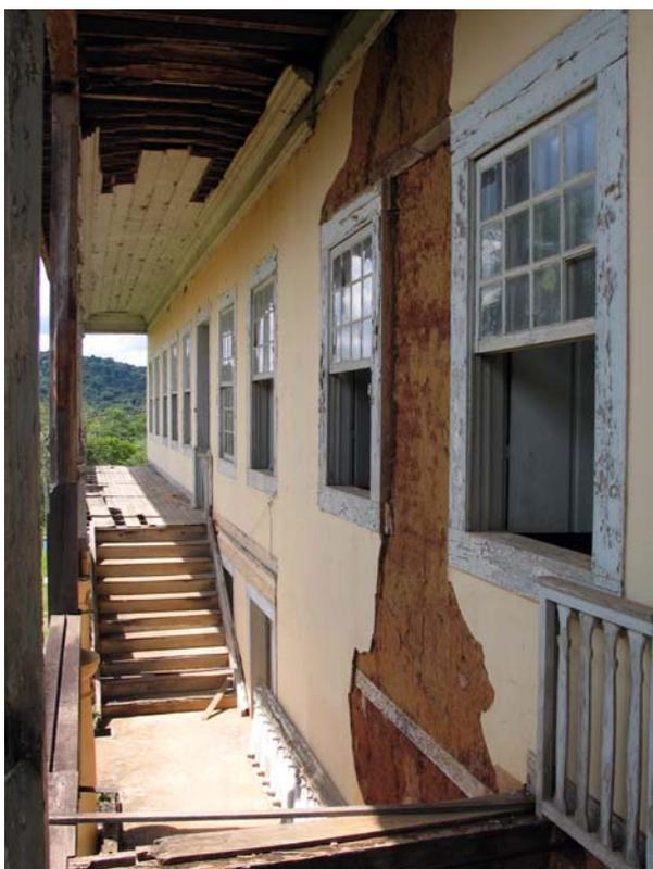
Figura 328 (acima) - Vista interna do alpendre da fachada, onde se pode ver a taipa de pilão na parede. Casarão da Fazendinha, ou fazenda Atibaia, Campinas. Foto: V. Benincasa.
