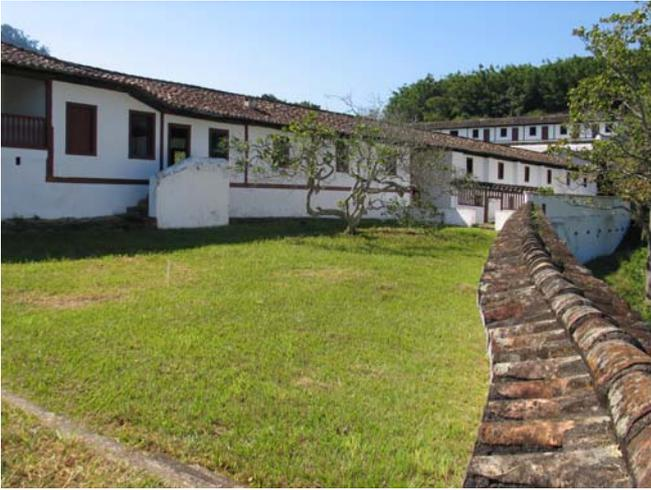
Figura 14 (à esquerda, topo) - Muro divisório coberto de telhas, fazenda Pau d'Alho, São José do Barreiro. Foto: V. Benincasa.
