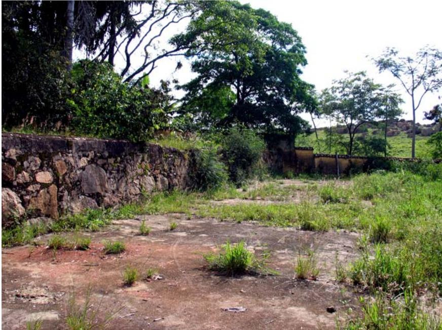
Figura 51 - Vista parcial de um dos patamares do terreiro da fazenda Floresta, Itu. Ao fundo, vê-se parte do muro de taipa de pilão que circunda todo o conjunto de edificações da fazenda. Foto: V. Benincasa.
