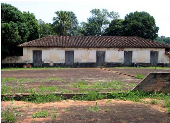
Figura 63 (à esquerda) - Tulhas de café, construídas com paredes externas em taipa de pilão, localizadas na parte inferior dos terreiros. Fazenda Engenho das Palmeiras, Itapira. Foto: V. Benincasa.
