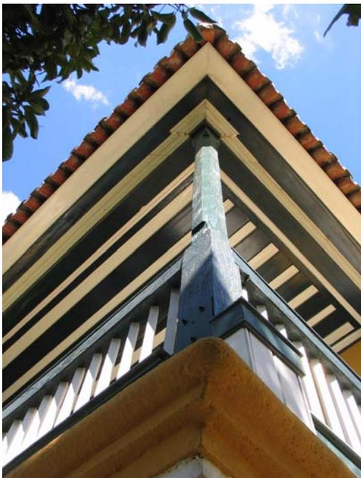
Figura 201 (à esquerda, topo) - Detalhe das pilastras de sustentação do piso do alpendre frontal. Casarão da fazenda Santa Maria, Campinas. Foto: V. Benincasa.
