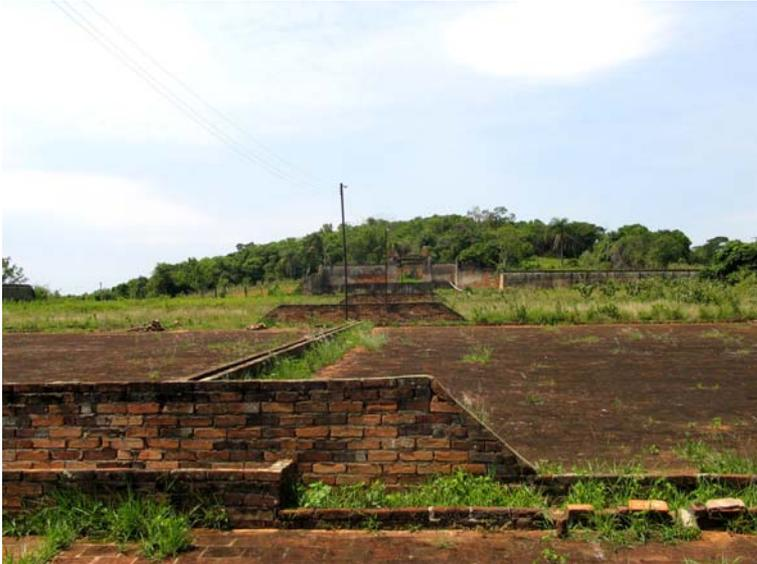
Figura 54 - Vista parcial dos terreiros, com os canis de distribuição e moegas de recepção de grãos. Fazenda Engenho das Palmeiras, Itapira. Foto: V. Benincasa.
