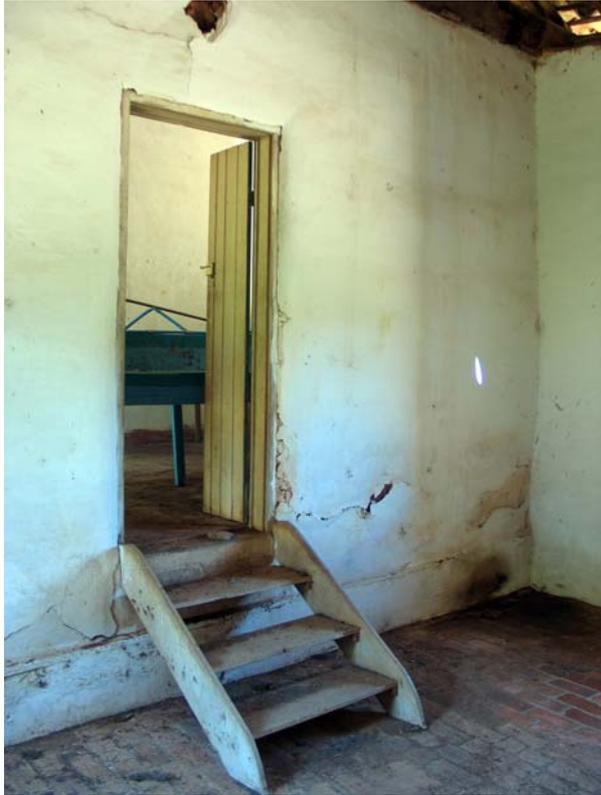
Figura 151 (acima) - Aspecto interno da senzala: porta interna aberta entre dois cubículos, em período posterior ao final da escravidão. As paredes externas são de taipa de pilão. Fazenda Pereiras, Itatiba. Foto: V. Benincasa.
