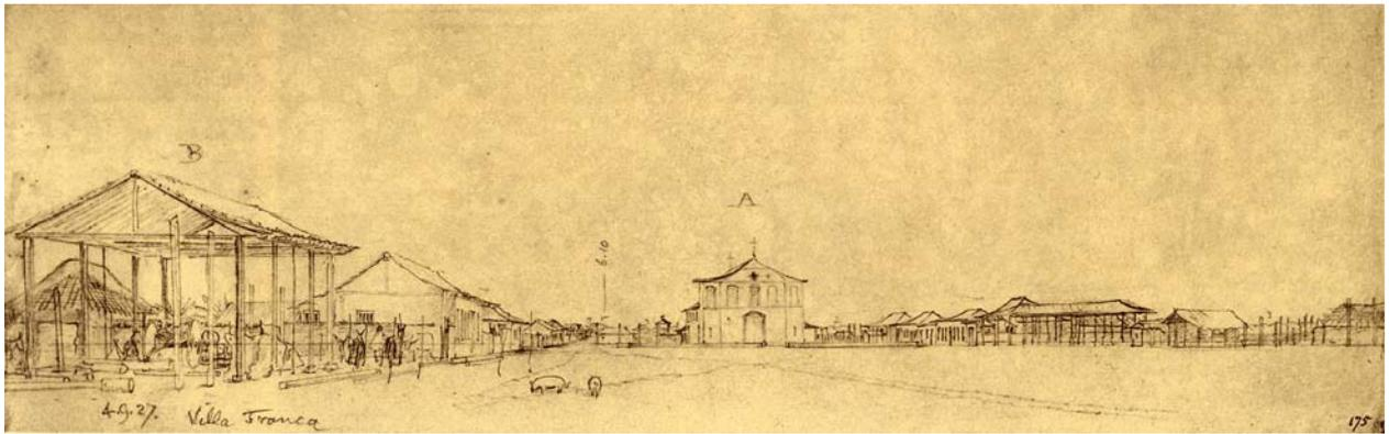
Figura 8 - Aspecto de Franca, em 1827, por Burchell. Notar a capela e as casas em que aparece a estrutura autônoma de madeira, preenchida por taipa de mão. Fonte: Ferrez, G. *Op. cit.*, 1981, p. 113.
