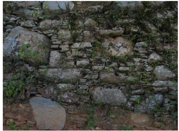
Figura 12 (à esquerda) - Muro do tipo canjicado, fazenda Resgate, Bananal. Foto: Vladimir Benincasa.
