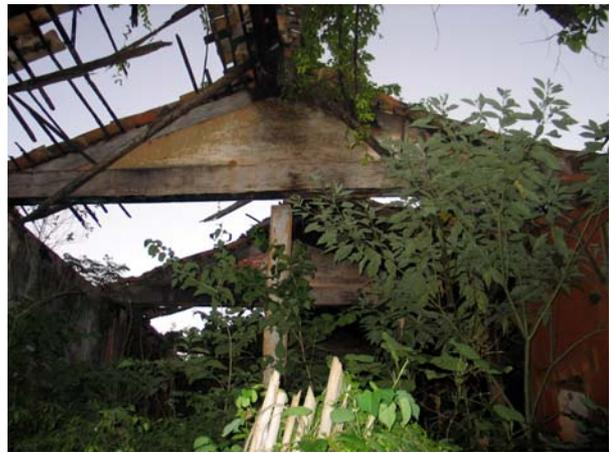
Figura 154 (acima) - Aspecto interno da senzala: a antiga porta do cubículo deu lugar a uma janela externa. Fazenda Pereiras, Itatiba. Foto: V. Benincasa.
