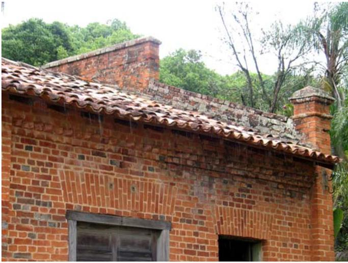
Figura 122 - Detalhe de fachada de casa de colônia, onde pode ser visto o arco de escarção sobre as aberturas e faixas com tijolos assentadas a 45°. Fazenda Vassoural, Itu. Foto: V. Benincasa.
