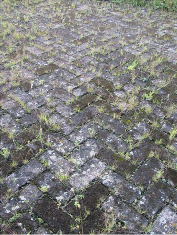
Figura 47 (acima) - Detalhe de piso de terreiros, com tijolos assentados em espinha de peixe. Fazenda Concórdia, Itu. Foto: V. Benincasa.
