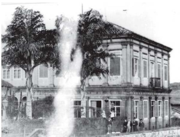
Figura 350 (acima, topo) - Fazenda Santana, Itatiba. Exemplo de casarão construído seguindo tendências do ecletismo arquitetônico: rusticação nas paredes, alpendre metálico, dois lances de escadarias monumentais. A construção no plano inferior, à direita, segue o mesmo padrão eclético. Fonte: AMARAL, Amadeu, et alli. *Almanach de Itatiba 1916*. Itatiba: Typographia d'A Reacção, 1916.
