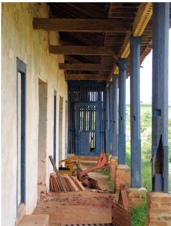
Figura 143 (à esquerda, topo) - Aspecto da edificação que abrigou a senzala e a casa de máquinas da fazenda São Miguel, Itatiba. Edificação cujas paredes externas são em taipa de pilão. Foto: V. Benincasa.
