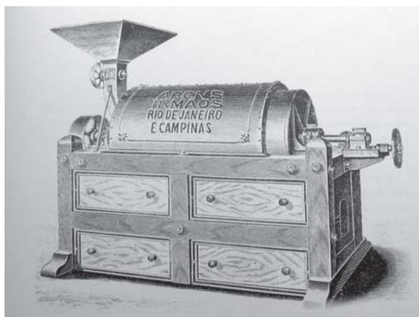
*Um esbrugador é pois um descascador rapido, em ponto pequeno, deste ou daquele typo. Um dos mais usados desbrugadores, em S. Paulo, é constituido por um tambor de 50 a 75 centimetros de diametro, e 20 a 50 centimetros de largura, (conforme a capacidade), revestido em sua superficie externa, de chapas fundidas estriadas ou de barras metallicas de vivas arestas.*
