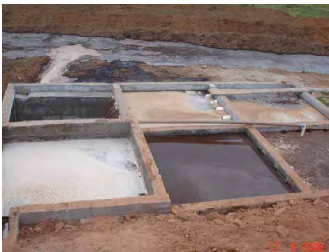
Figura 6 – Tanque de decantação da ARC (Água residuária de café).
